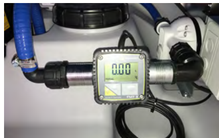
Zähler FMT 3 mit Impulsausgang
