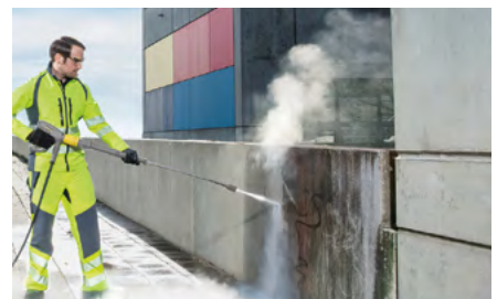
Hochdruckreinigung mit bis zu 200 bar
